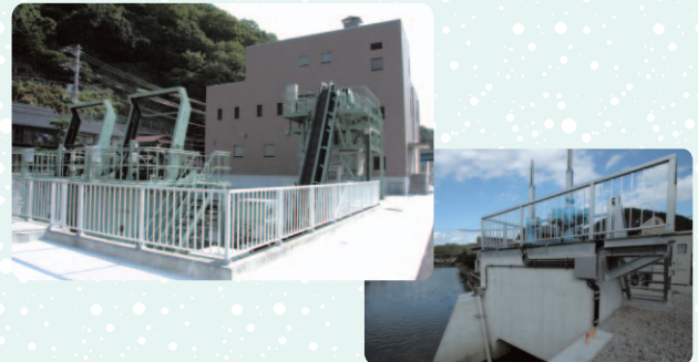
▲ 新倉ポンプ場(左)と西町ポンプ場(右)が完成
