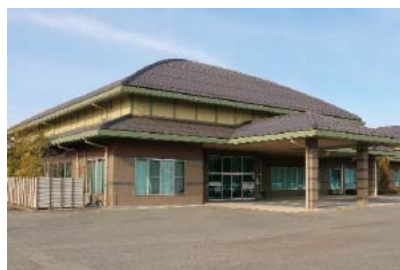
▲改修工事が始まる久井保健福祉センター
