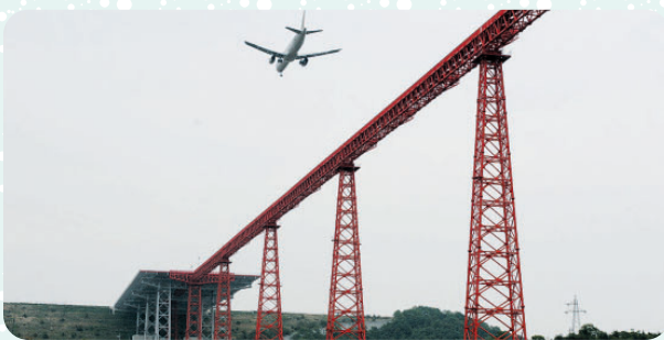
▲新システムの設備(人工地盤と灯火設備) 欠航や着陸地変更の9割程度が解消されます
