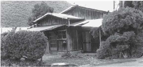
中之町処迫住宅
