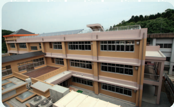
▲連絡用通路の両側には、テラスを設置
