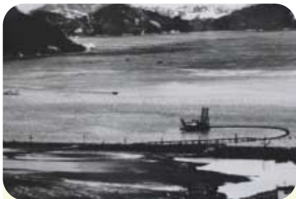
船からパイプが延びている干拓工事のようす
