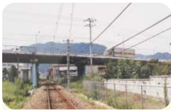
J R呉線が国道2号の高架下を通過していた頃 (昭和56年)
