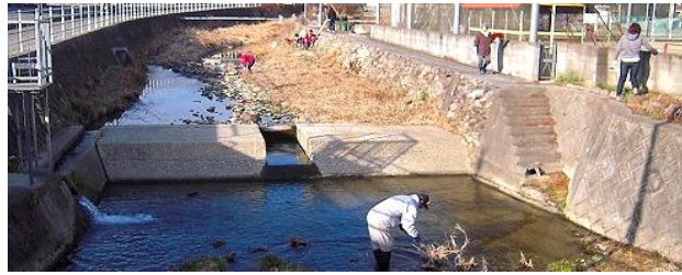
深町の藤井川。深小学校付近での清掃状況。
