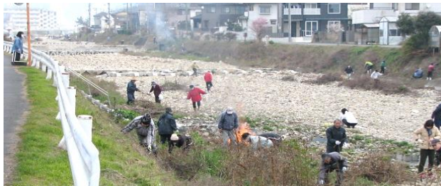
中之町の和久原川。東高校付近の作業状況。
