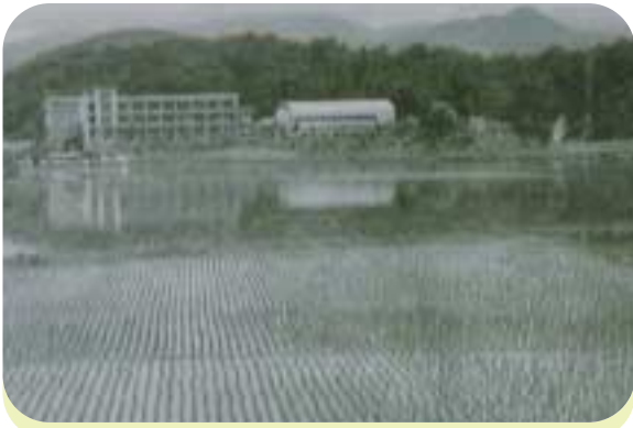
昭和44年、豪雨による冠水被害
