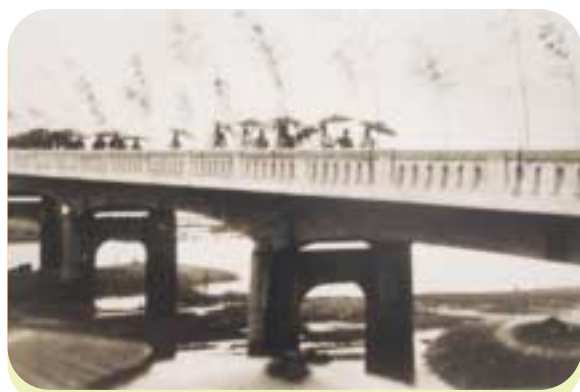
昭和11年、沼田大橋竣工祭の渡り初め式
