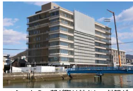
▲シートの一部が取り外され、外観が現れた新庁舎(1月21日撮影)
