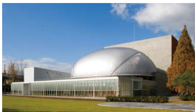
▲遮音対策のために改修工事を行う芸術文化センターポポロ
