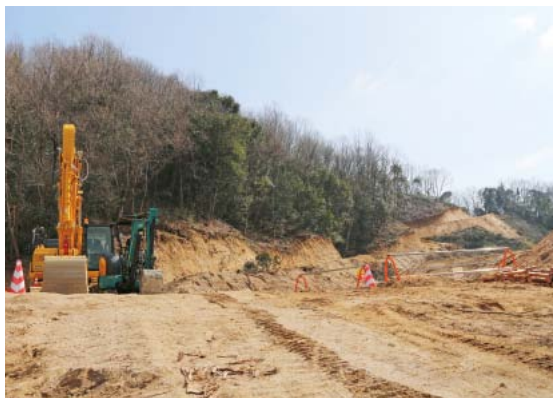
▲造成工事が進む本郷産業団地
