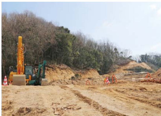
▲造成工事が進む本郷産業団地
