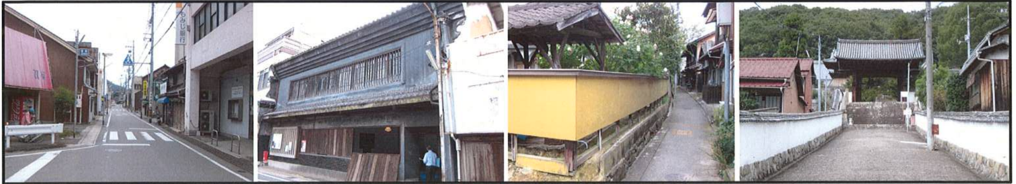
改修した旧家をアートイベントに活用
