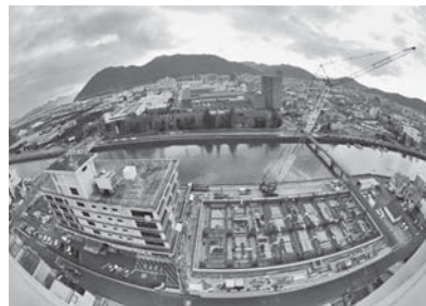
建設中の新庁舎
