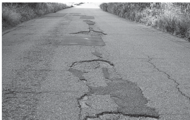
路面の損傷
