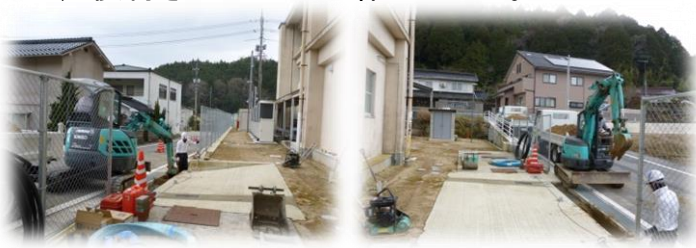
水道接続工事の様子
