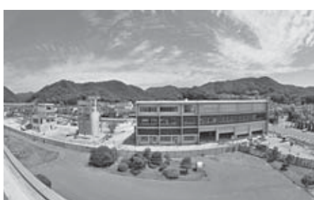
建設中の消防庁舎
