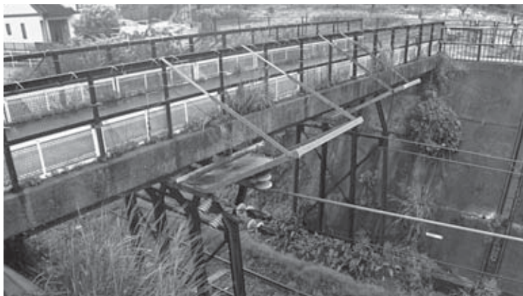
市道幸崎36号線1号橋梁
