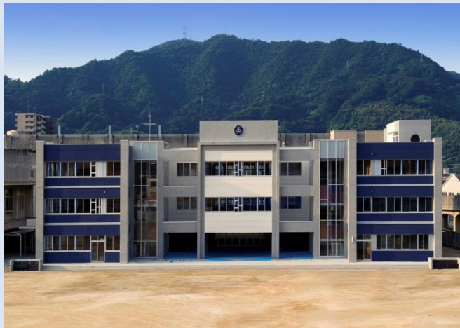
平成28年8月 北からの新校舎
