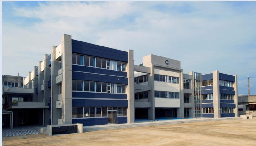
平成28年8月 北からの新校舎
