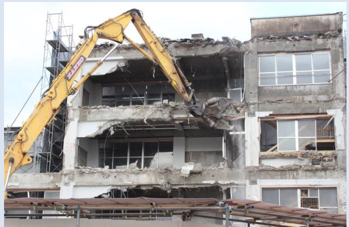
平成29年3月 北校舎解体終盤
