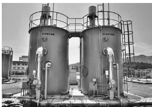
大和の浄水場急速ろ過機
