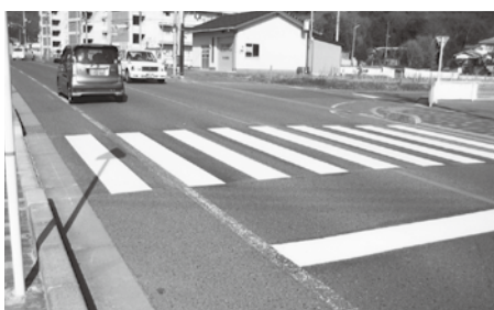
死亡事故が起きた主要地方道尾道三原線（中之町）
