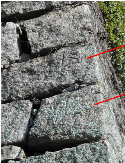
〔 五番櫓石垣隅部 〕
