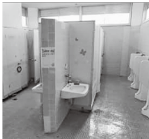
三原小学校のトイレ
