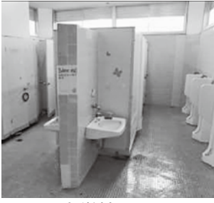
三原小学校のトイレ
