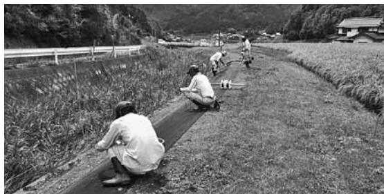
大規模柵の設置の様子
