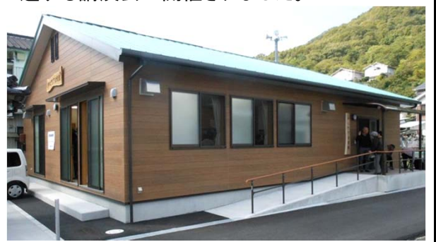
51年ぶりに立替られた新公民館。町内活性化・防災の拠点としての活用が期待されます。
