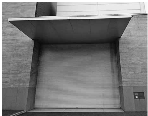
ステージ裏の搬入口【シャッターが閉まった状態】
