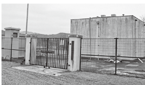
廃止される大和工業団地用水供給施設
