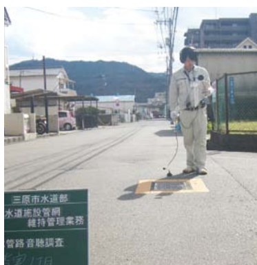
▲漏水調査の様子
