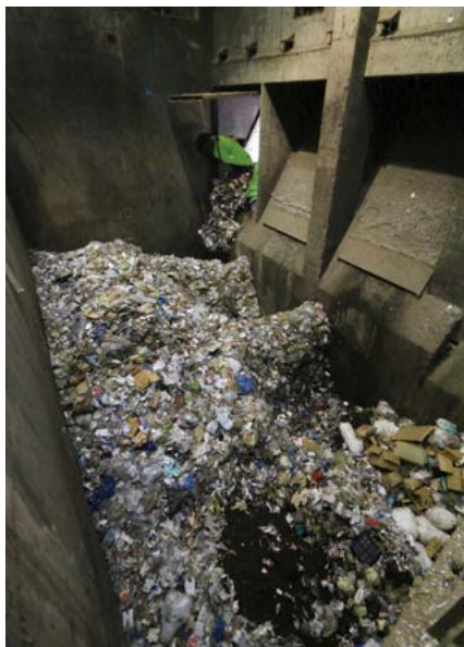
◀清掃工場のごみ搬入ピット
