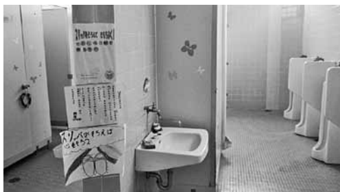
改修が急がれる狭く臭う小学校トイレ
