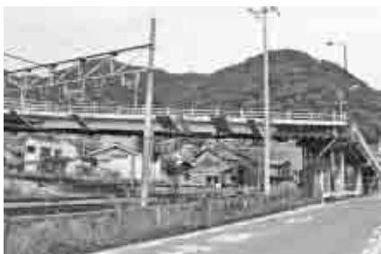
市道糸崎122号線3号橋梁
