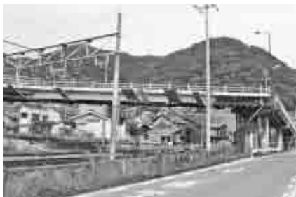
市道系崎122号線3号橋梁
