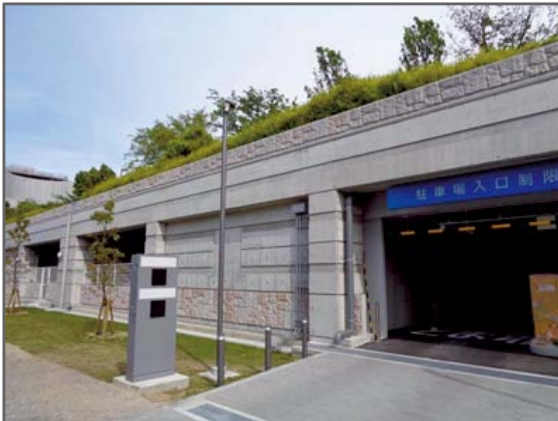
(イメージ例)人工地盤型駐車場
