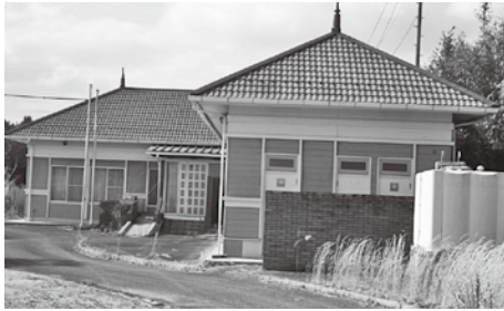
久井運動公園研修棟
