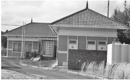
久井運動公園研修棟
