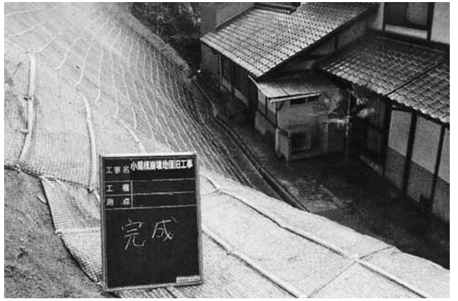
復旧が完成した小規模崩壊地
