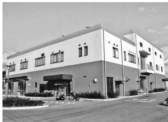
汚泥再生処理センター
