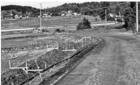
市道野間線の改良状況
