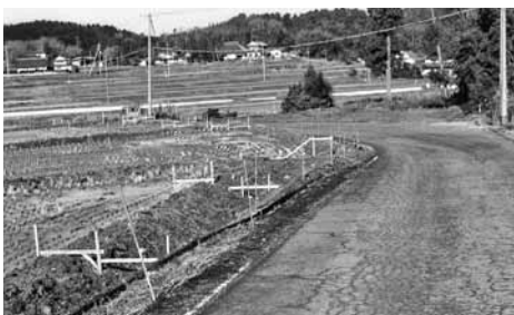
市道野間線の改良状況
