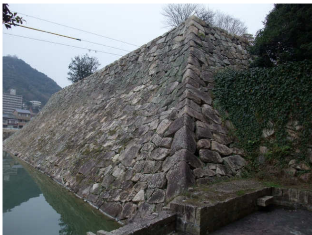
(上) 三原城跡 天主台 南西隅の石垣 三原城の石垣の中で最も古く、小早川隆景時代のもと考えられます。
