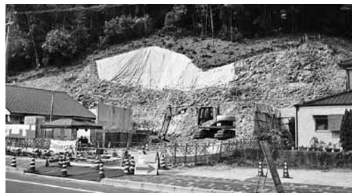
急傾斜地崩壊対策工事（中之町）
