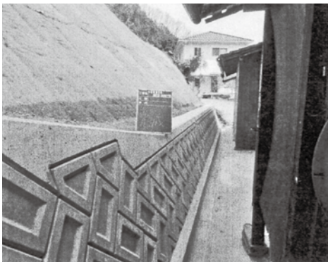
完成した小規模崩壊地復旧事業
