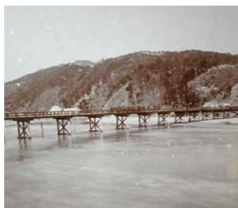
▲木造のころの定屋大橋(雙照院提供)
