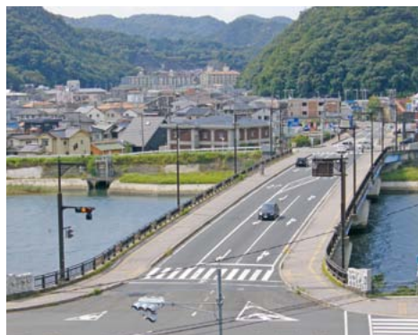
▲現在の定屋大橋
