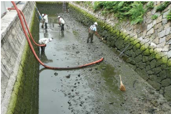
▲水をくみ上げ、底にたまった汚泥を取り除きました
