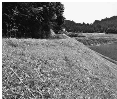
市道法面に安全対策を望む
