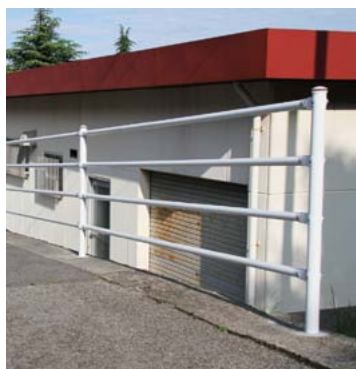
▲市民の声をを受けて設置した転落防護柵
