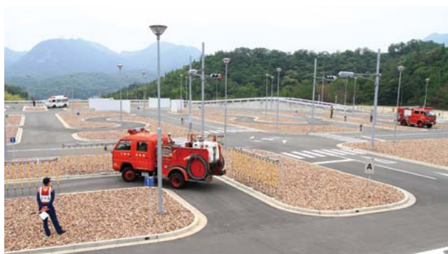
▲難しいコースで消防車両の運転技能を訓練しました
