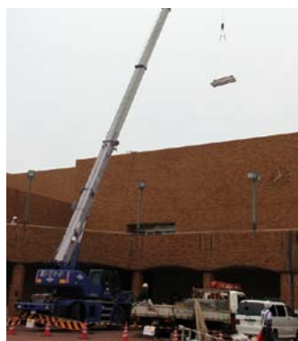
▲空調設備工事が進むリージョンプラザ
