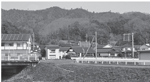
未着工の空港記念公園予定地
