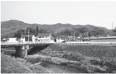
未着工の空港記念公園予定地
