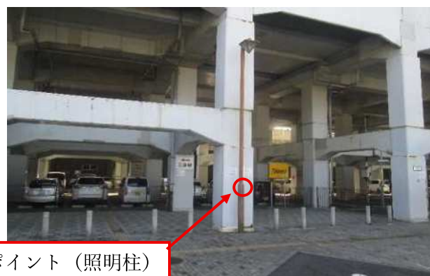
写真5 変位計測基準点（照明柱、橋脚）
