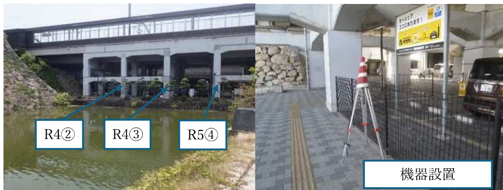
写真1 水平・垂直変位計測 の対象物(橋脚)
