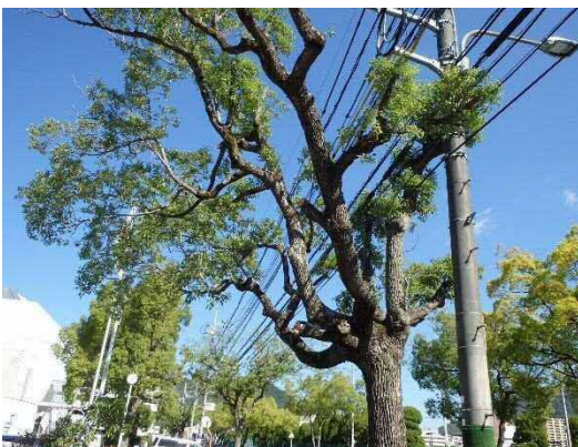
強剪定による樹形の悪化（架線との干渉）
