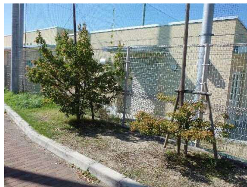
植栽基盤の未整備による先枯れの発生
