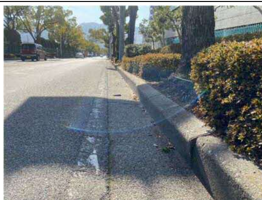
車道側への縁石の持ち上げ
