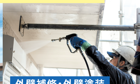
外壁補修・外壁塗装
