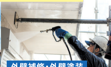
外壁補修・外壁塗装
